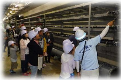
地下探検 共同溝の説明
