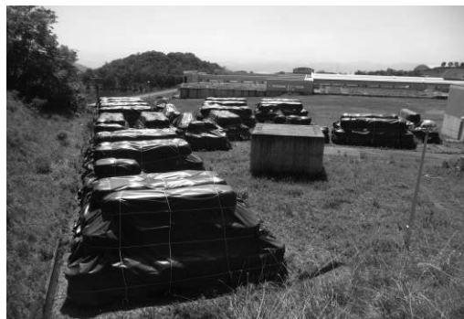
浄水ケーキの仮置状況
