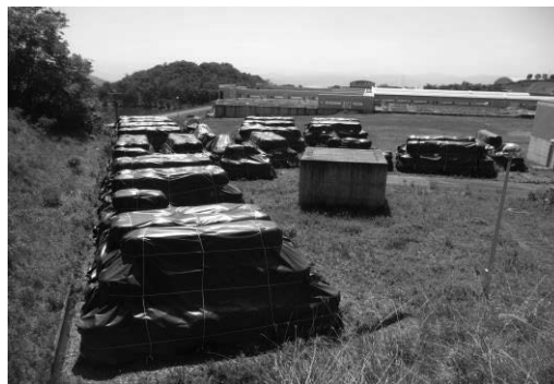
浄水ケーキの仮置状況
