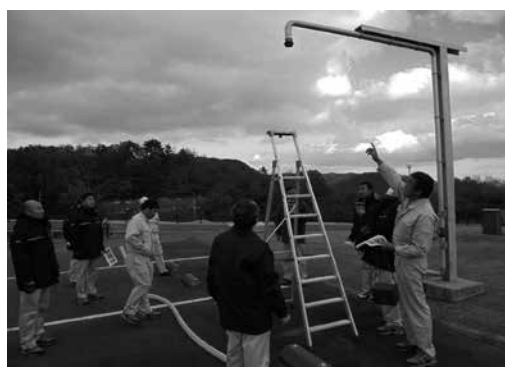
応急給水訓練状況
