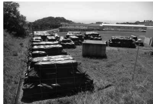
浄水ケーキの仮置状況
