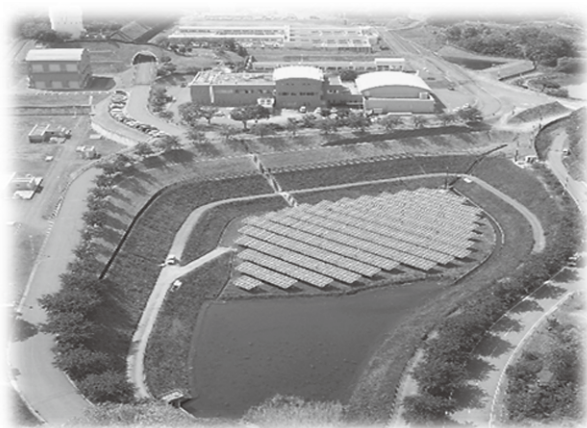
すりかみ浄水場太陽光発電所 (A 調節池)
