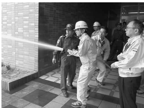
屋内消火栓操作訓練状況
