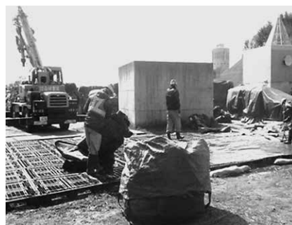
浄水ケーキ搬出作業の様子
