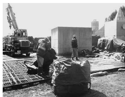
浄水ケーキ搬出作業の様子
