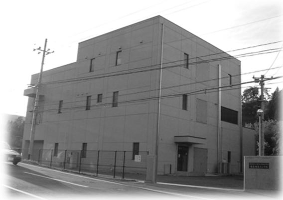
福島増圧ポンプ所小水力発電所
