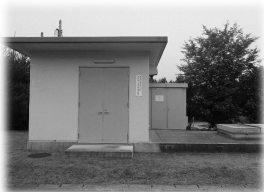
保原第二受水池流量計室
