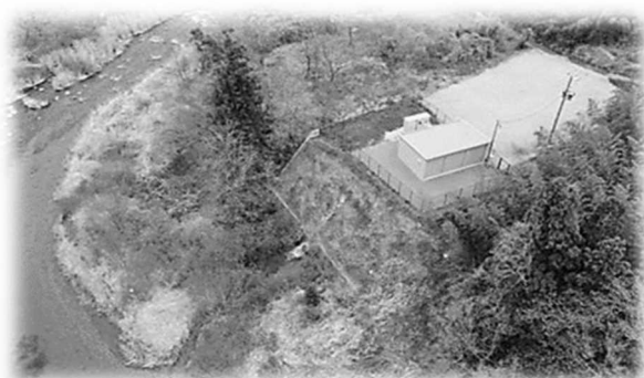
すりかみ浄水場小水力発電所（緊急放流施設）
