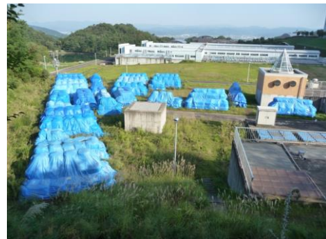
浄水ケーキの仮置き状況
