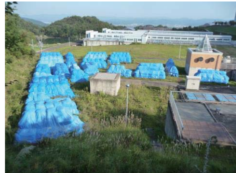
浄水ケーキの仮置き状況
