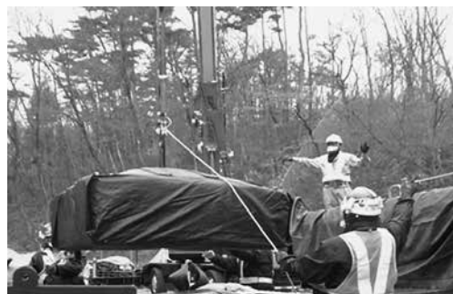
浄水ケーキ搬出作業の様子
