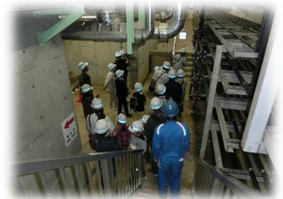
地下探検 共同溝見学
