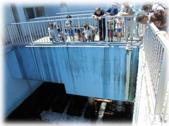
「急速ろ過池」にて汚れを取る「逆洗」の見学
