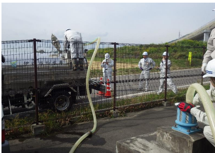
給水車へ注水作業の状況です。 (桑折幹線流量計室)
