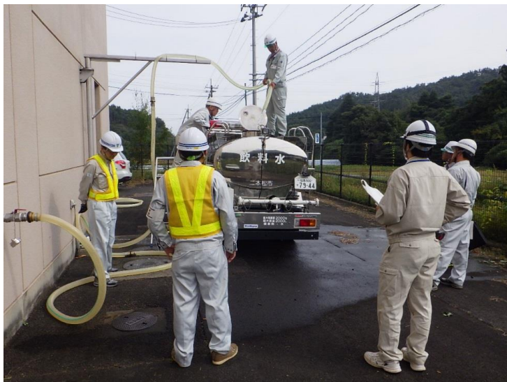
給水車へ注水作業の状況です。 (福島増圧ポンプ所)
