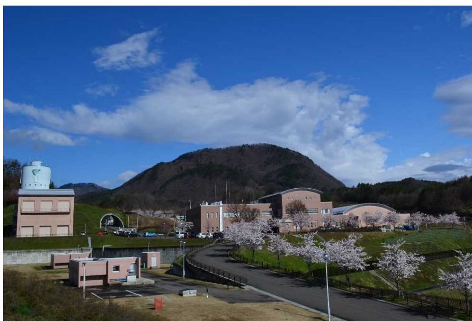
(すりかみ浄水場)
