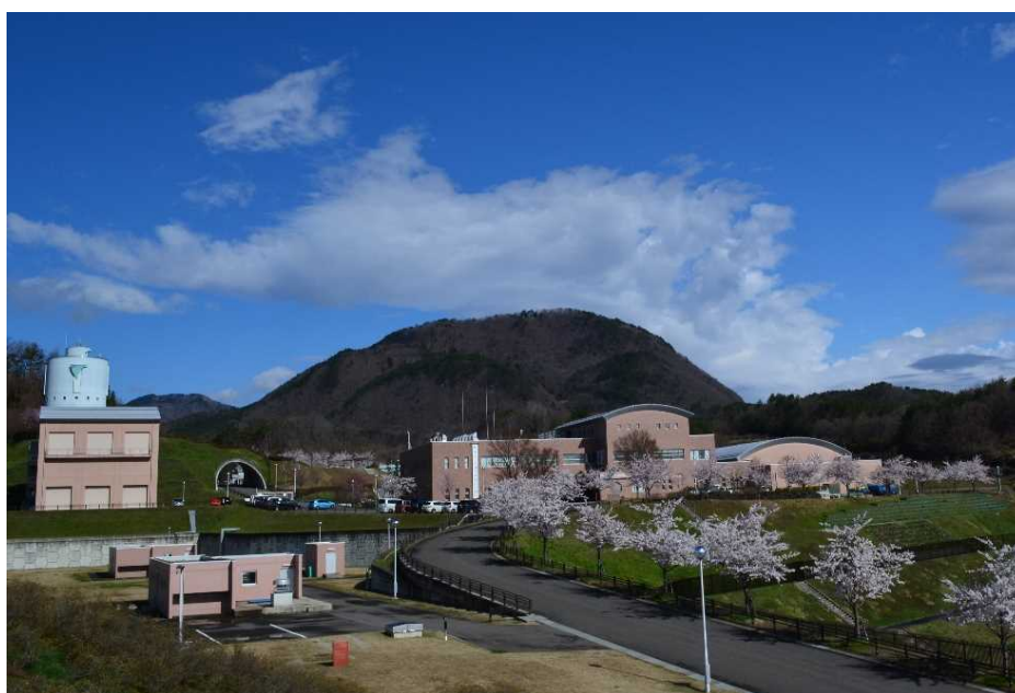
(すりかみ浄水場)
