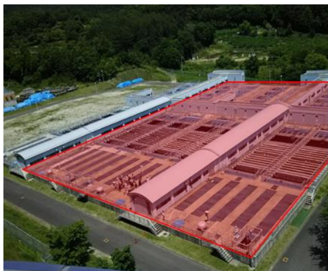
(沈澱・ろ過池写真)
