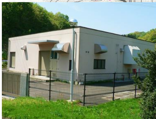
(月館第二増圧ポンプ所)
