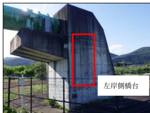
(八反田水管橋)
