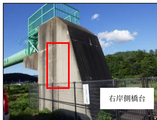
(北八反田水管橋)
