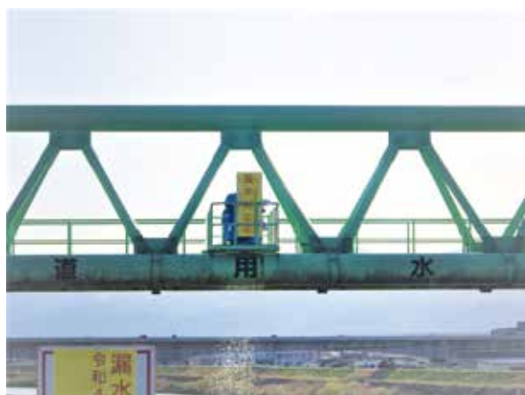
伏黒水管橋の空気弁※22破損による漏水
