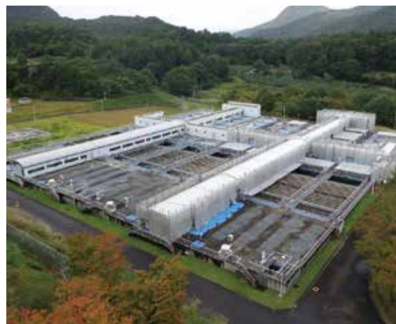
すりかみ浄水場浄水施設
