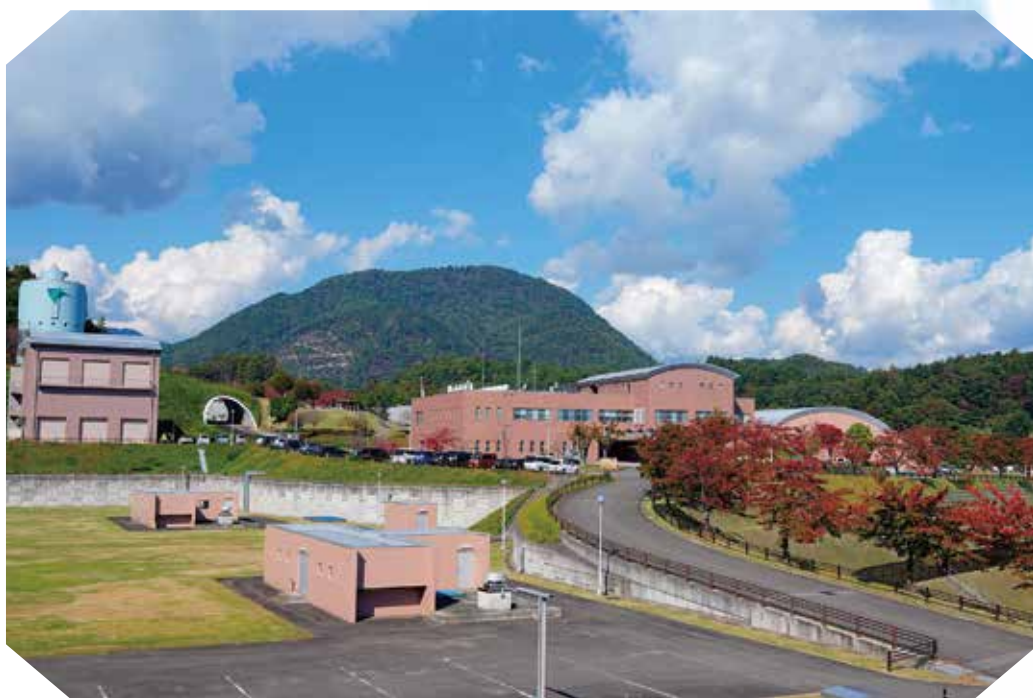
すりかみ浄水場
