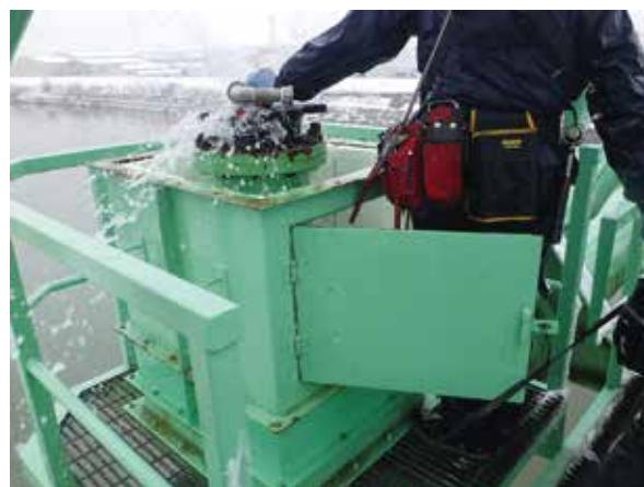
伏黒水管橋の空気弁※22破損による漏水
