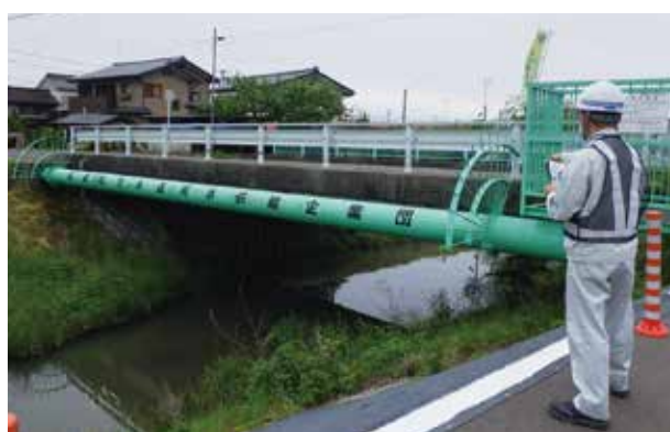
施設点検訓練
