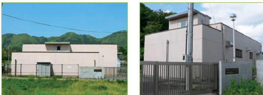
月館第一増圧ポンプ所
