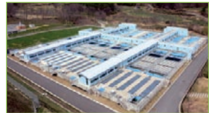
すりかみ浄水場薬品沈でん池・ろ過池
