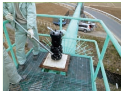
大森川水管橋空気弁からのエア-抜き状況
