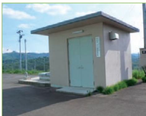
保原第一受水池流量計室
