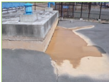
桑折幹線流量計室敷地の地盤沈下状況
