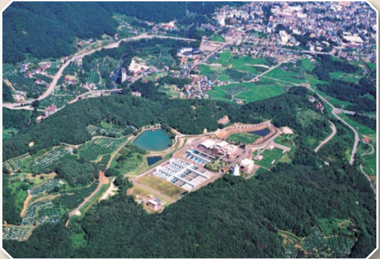
すりかみ浄水場全景
