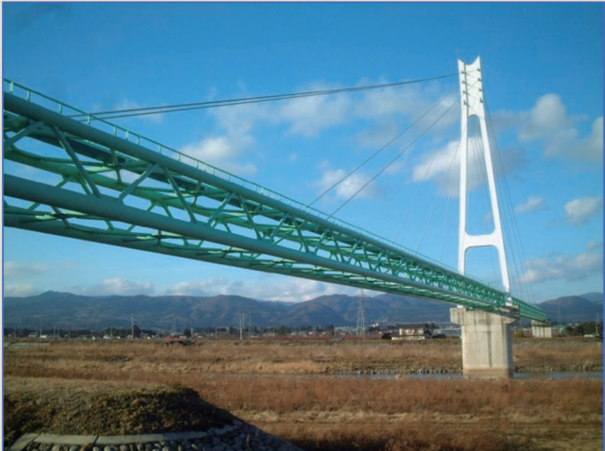
仁井田水管橋
