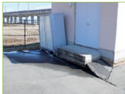
桑折幹線流量計室敷地の地盤沈下状況
