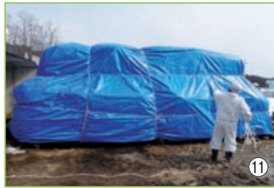
⑩ シート梱包 ⑪ ロープ結束 ⑫ ロープ結束完了
