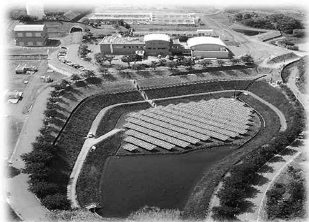
すりかみ浄水場太陽光発電所 (A 調節池)
