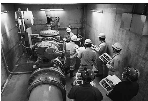
応急給水支援設備操作説明状況
