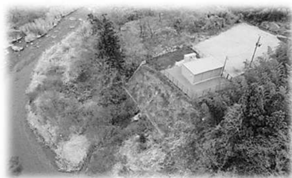
すりかみ浄水場小水力発電所(緊急放流施設)
