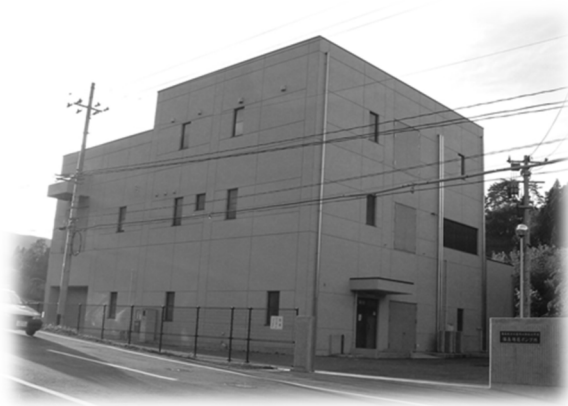
福島増圧ポンプ所小水力発電所
