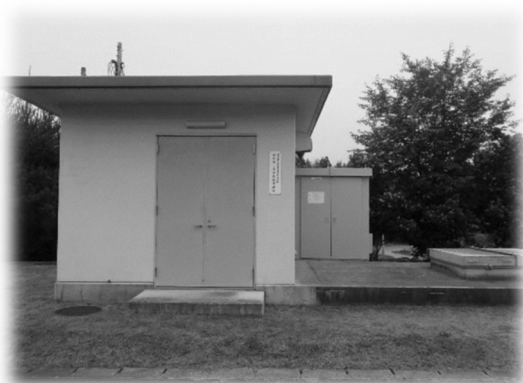
保原第二受水池流量計室
