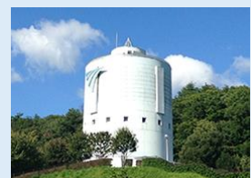
13 排水処理施設
