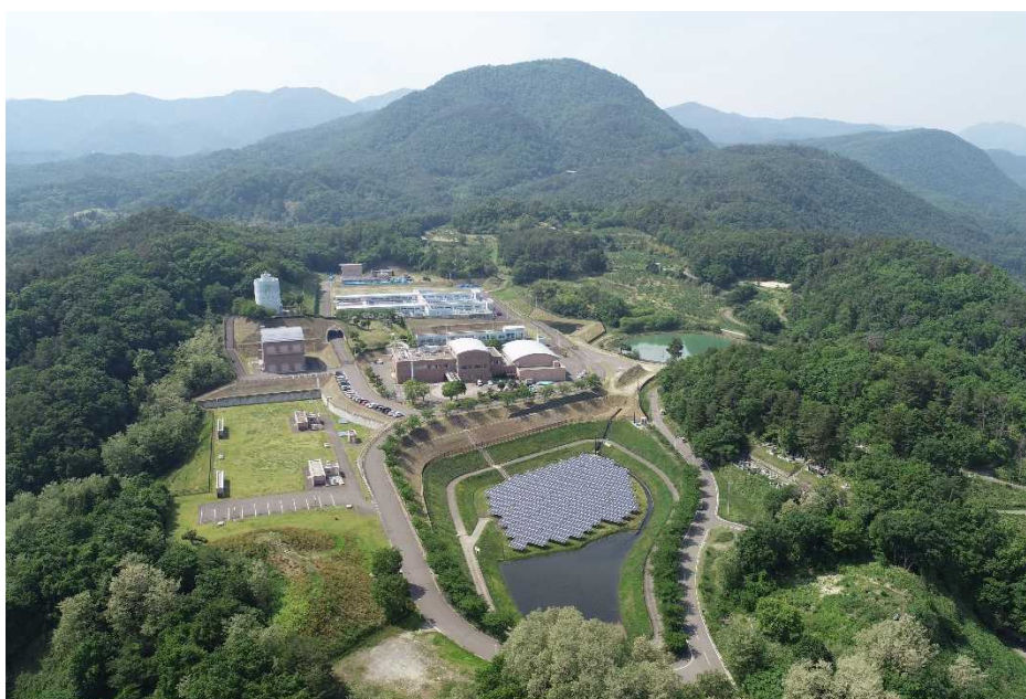
(すりかみ浄水場)
