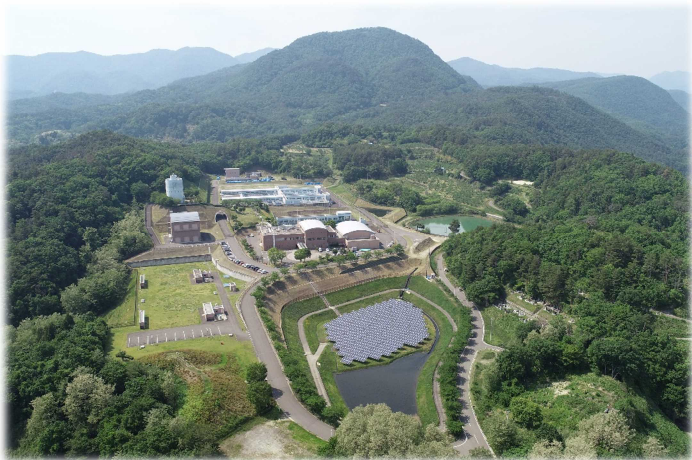
(すりかみ浄水場)
