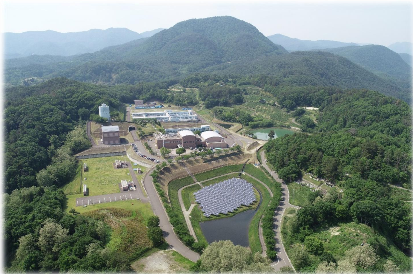
(すりかみ浄水場)
